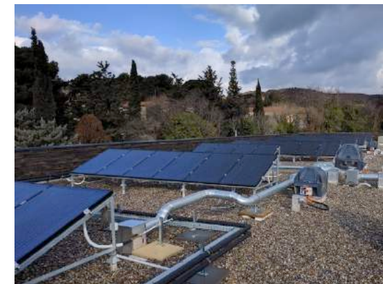
EHPAD, hôpitaux, hôtels, campings
