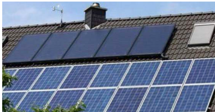
Panneaux thermiques + photovoltaïques
