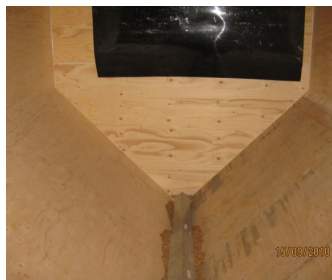
Pans inclinés en OSB avec pointe de diamant en fond de vis (à gauche) ou pans inclinés en planche contre- plaqué (à droite).
