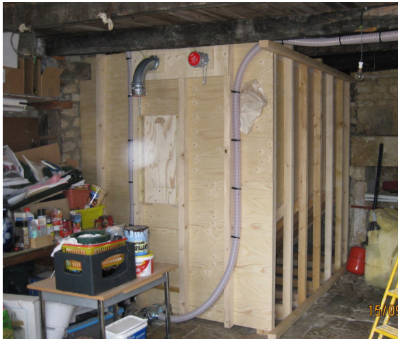
Pièce de réserve en panneaux de bois dans une cave
