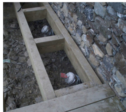
Raccords sous le niveau du sol
