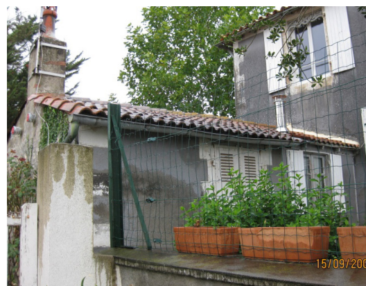
Dans cette photo se cachent deux bouches de remplissage
