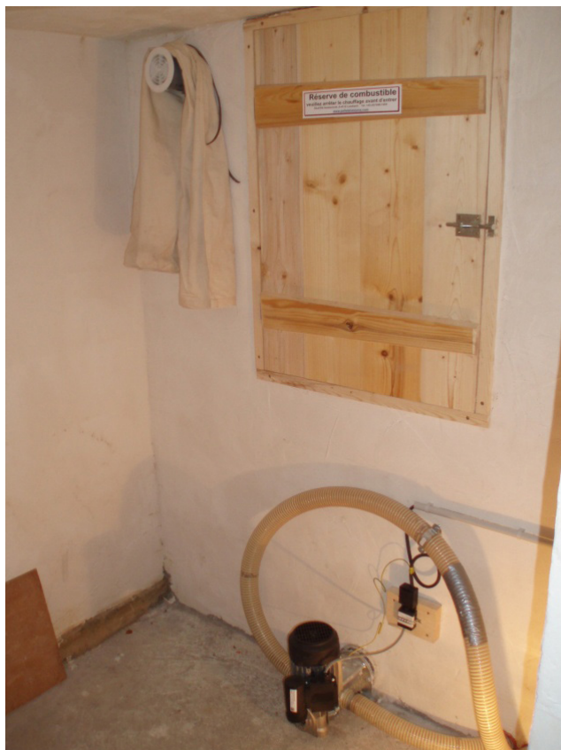
Extérieur d'une pièce de réserve maçonnée
