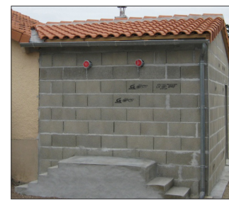
Bouches de remplissage classiques
